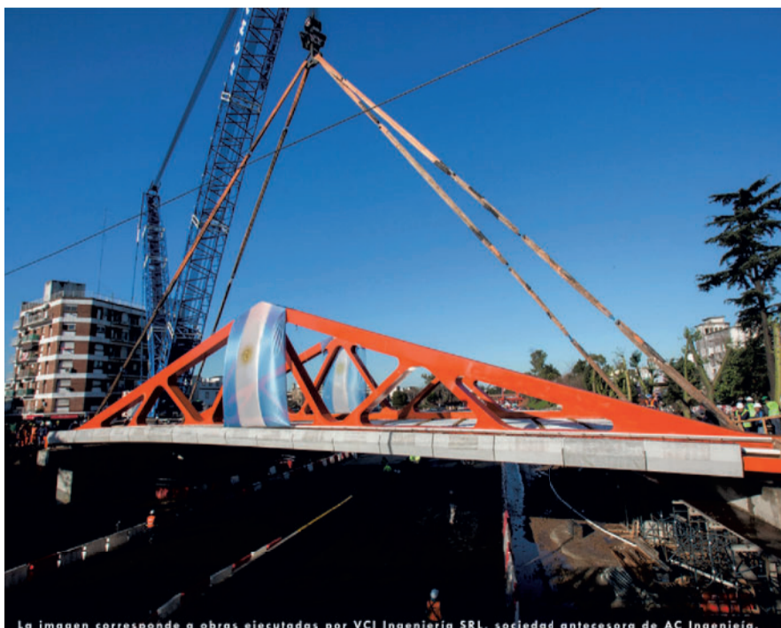
PUENTES DE ACERO SOBRE AV. GENERAL PAZ
