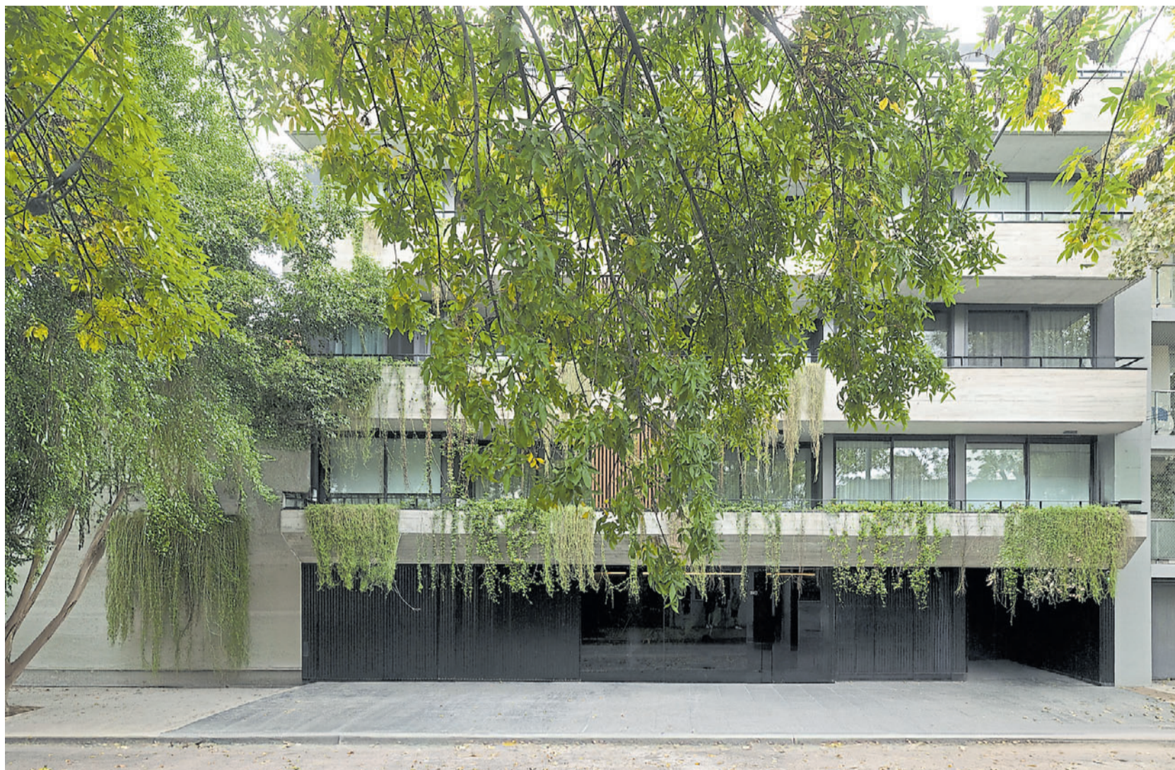
5 GUAYRA. Desde el punto de vista volumétrico, el edificio posee balcones corridos al frente que exaltan la longitud y linealidad de la fachada. Se conforman mediante parapetos de hormigón visto combinando la tectonicidad del material con una frondosa vegetación colgante que termina por definir la fachada.
