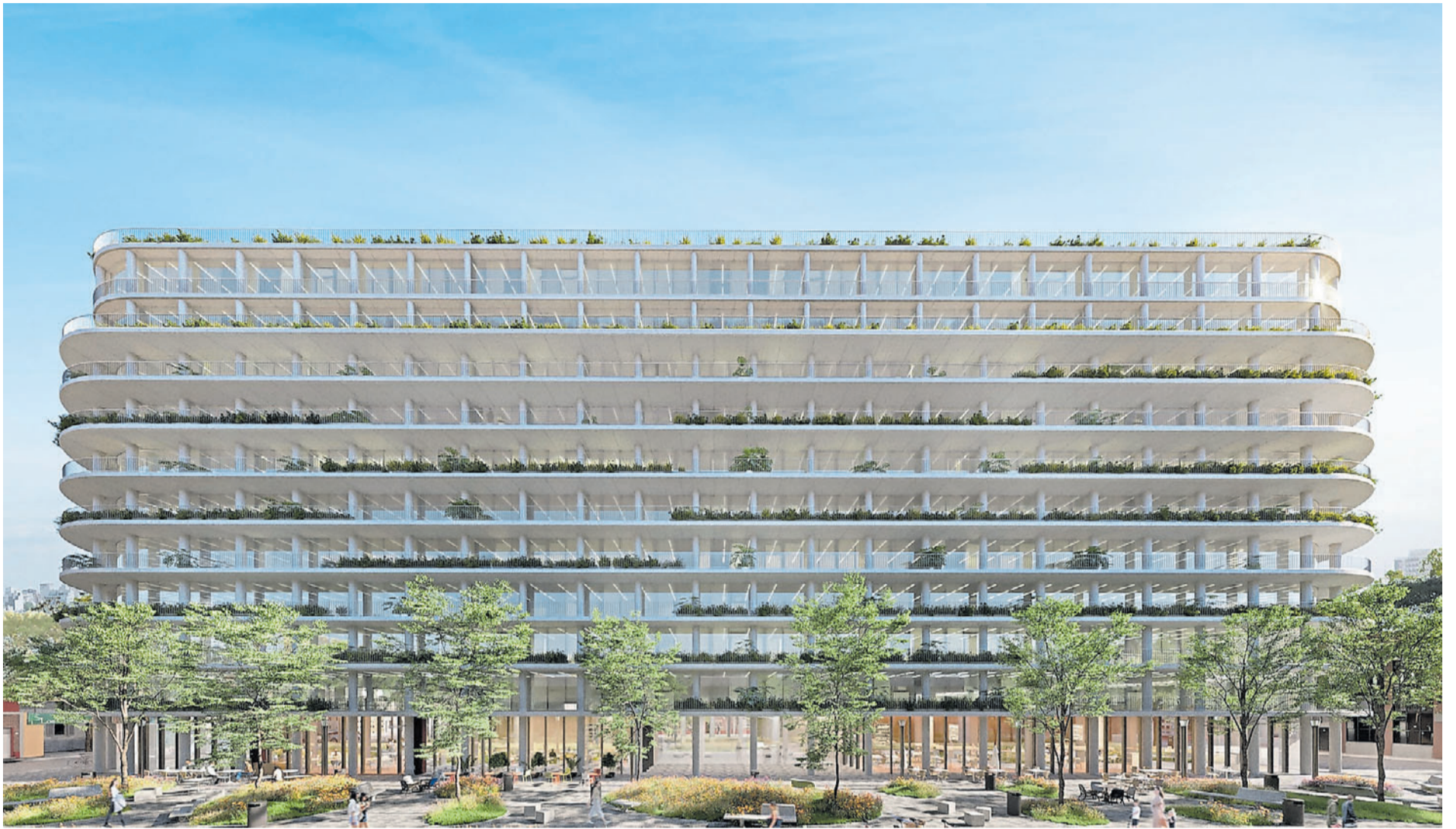
MIRABILIA 851. En este edificio corporativo ubicado en Villa Crespo se aplicó la tecnología para minimizar el consumo energético, con control inteligente de la iluminación.
